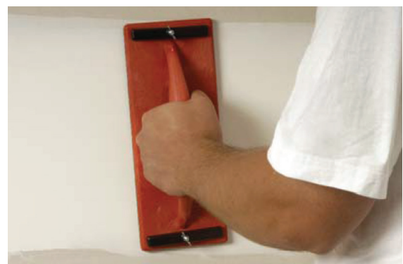
6 3차 코트가 완전히 건조되면 샌딩하여 마감을 하거나 필요에 따라 추가 전면퍼티 후 샌딩하여 마감 합니다.
