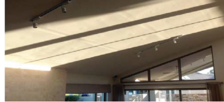
측광이 있을 때의 석고보드면 예시
